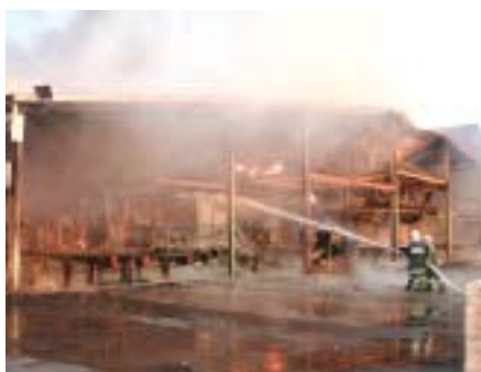
Löscharbeiten bei dem Unfall in Ybbs
